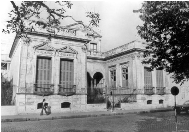
Figura 5 – Casarão eclético de Pelotas tombado em 1977 Fonte: Arquivo Central do Iphan/RJ
