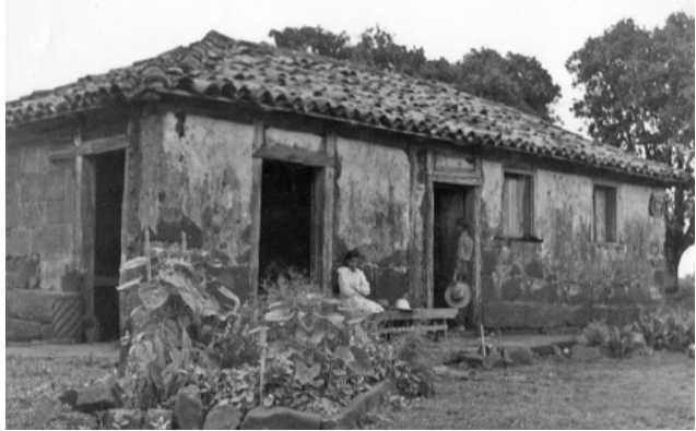
Figura 3 – A vernacular casa de material missioneiro Fonte: Arquivo Central do Iphan/RJ
