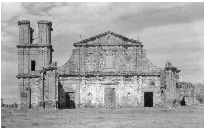
Figura 1 – Ruínas da igreja de São Miguel Arcanjo nas Missões Fonte: Arquivo Central do Iphan/RJ
